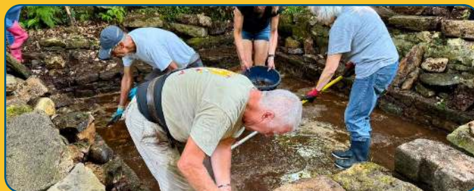
Le lavoir de Luzurtul - Chantier du CNP
