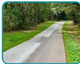
Travaux de PATA route de Kerverry
