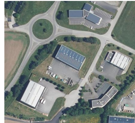
Panneaux solaires sur un bâtiment économique à Troyalac'h Sud - (Source : Géoportail)
