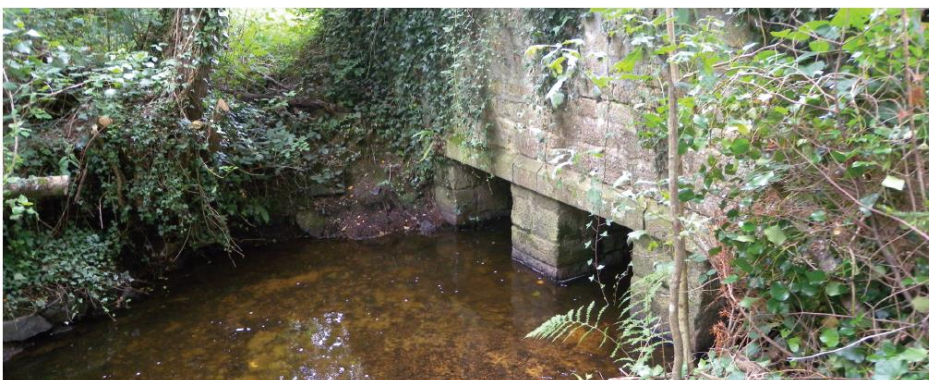
Un ouvrage d'art intéressant sur le cours du ruisseau du Mur, dans l'ensemble peu accessible.
