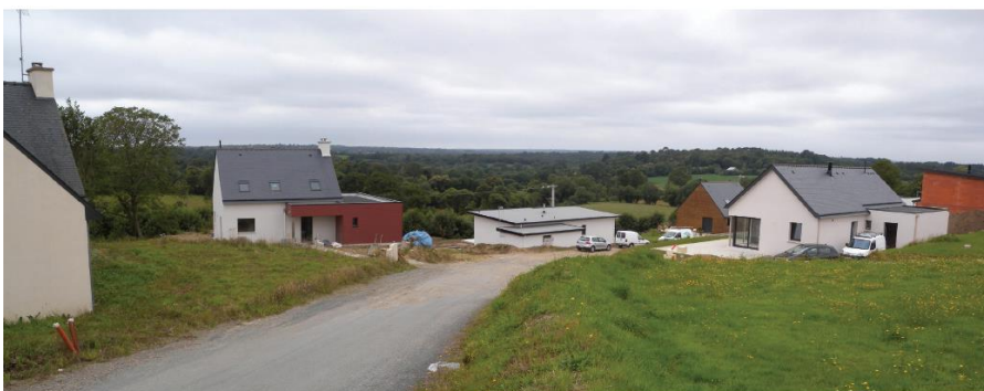
Lotissement récent rue de Doumeur, en belvédère sur le grand paysage vers Cosquer. La beauté des vues est-elle intégrée dans l'espace public ?
