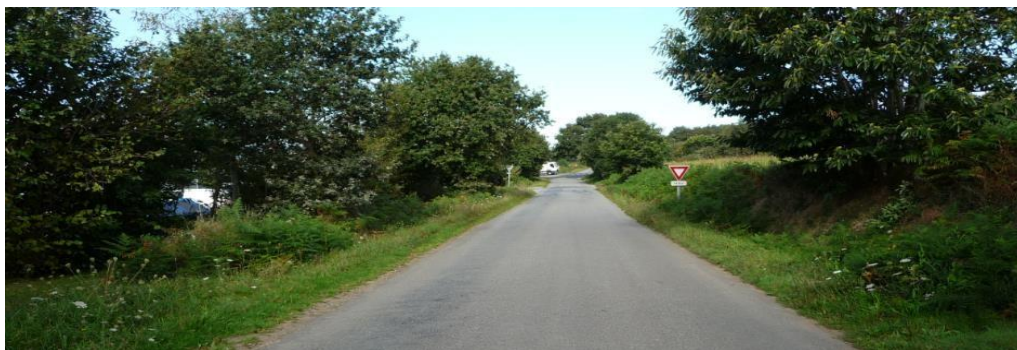
Le chemin de Ménez Bras Névez bordant le Sud de la zone d'extension « Nord-Ouest » (Source : Futur Proche)
