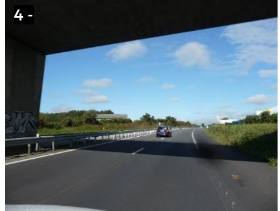
Au passage sous la rue Jean Cuéguen, le secteur « Nord-Ouest » devient fortement visible. Au Nord de la voie, les constructions dominent la RN 165 (voie encaissée).
