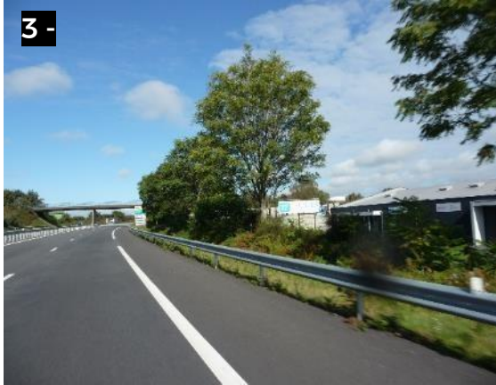
Des végétaux ponctuent par endroit la traversée le long de la zone d'activités. Ils créent un masque ponctuel et rythment le paysage de la ZA depuis la RN 165. Le secteur de la future extension de la zone au Sud de la voie apparaît.
