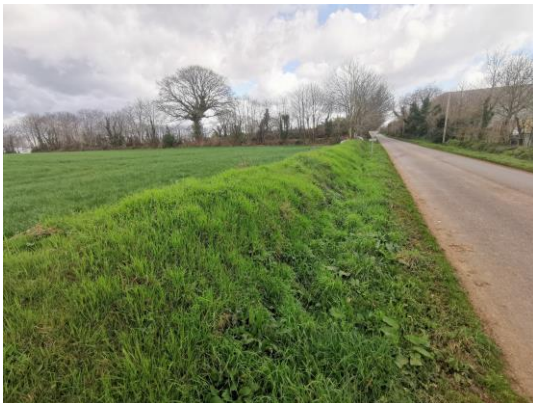
Talus nu en bordure Sud du secteur (Source : Envolis)
