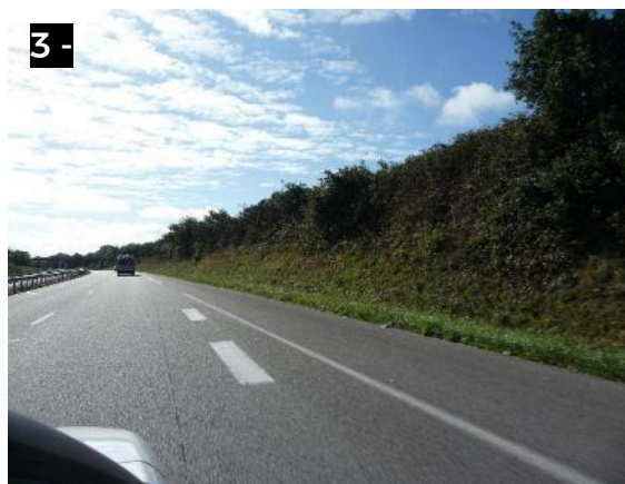
La voie est encaissée par rapport au site de projet d'extension de la ZA. Il n'y a donc actuellement aucune visibilité sur le site.
