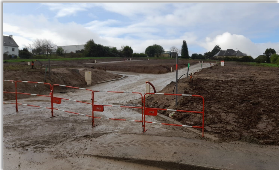
Le lotissement de Keromen en cours de viabilisation
