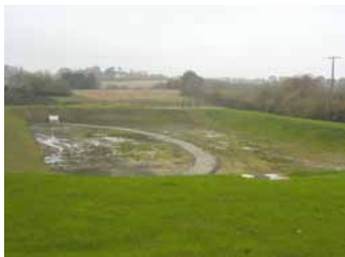
Bassin de rétention Zone de Troyalac'h
